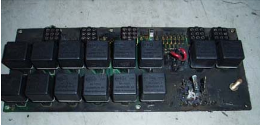
Kuva 7. Ajoneuvon vauriot rajoittuivat sähkökeskuksen piirilevyyn.
